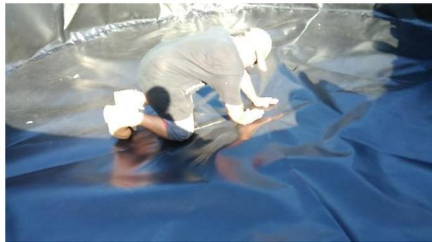
6) Passar cola entre o ralo de dreno e o fundo do tanque e logo em seguida arrebitar o anel de fibra por cima. Depois aplica cola PU entre a aba da caixa sifonada e a lâmina do bolsão. Esta cola veda completamente a passagem da água.
