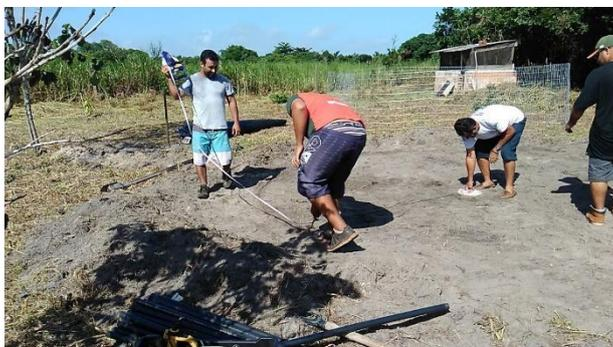
3) Observe a risca no chão. Em seguida abra as covas para instalação dos postes. Para obter a distância entre os postes é preciso dividir a circunferência da tela pela quantidade de barras. De preferência, concretar o buraco junto com os tubos para que fiquem mais firmes ou compacte a cova com pedras. Os postes devem ficar mais ou menos 1,20m do solo.
